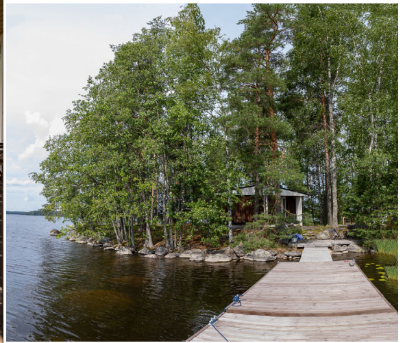
Asuinrakennus nähtynä kaakosta laiturin päästä.
