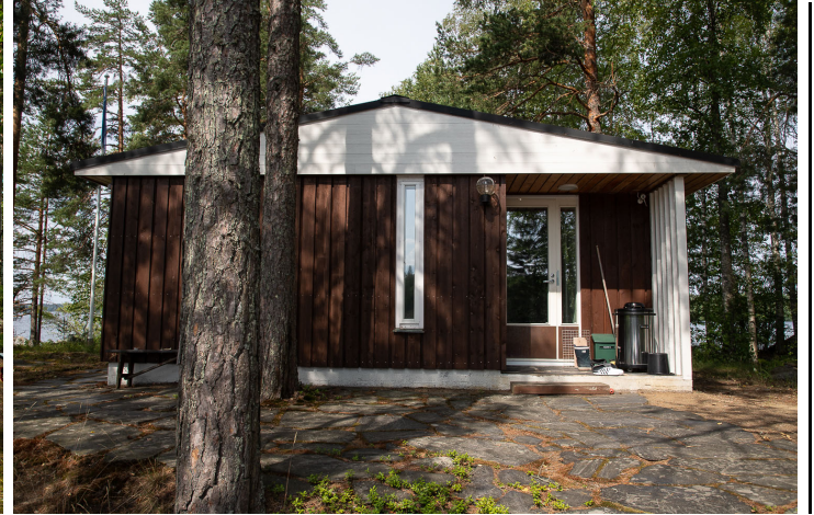
Asuinrakennuksen kaakkoispääty, jossa on vuonna 1991 tehty laajennus.
