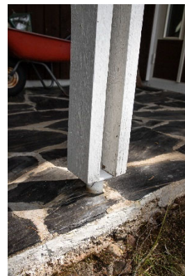
Liuskekivipintaisen terassin pilarin yksityiskohta.
