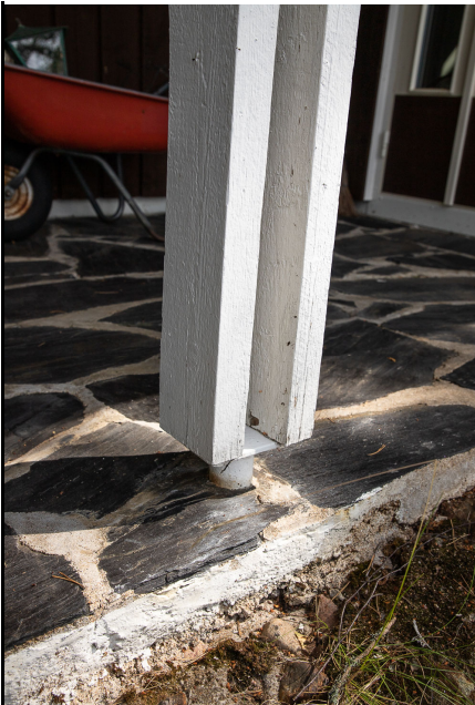
Asuinrakennuksen terassin pilari.
