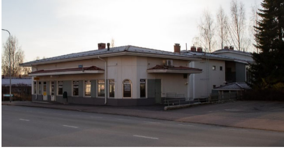
Korttelissa 76 sijaitseva yksikerroksinen liikeyrakennus, jossa toimii pizzeria.
