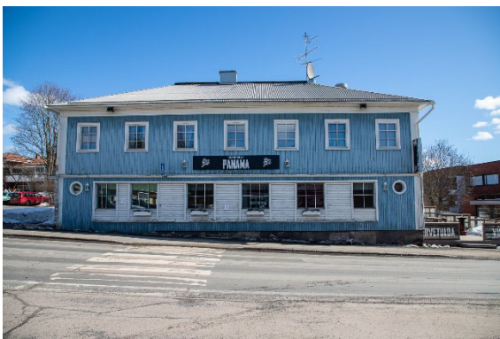
Korttelissa 117 sijaitseva ravintolarakennus, jonka toisessa kerroksessa on asuntoja. Rakennus on rakennettu 1900-luvun alkuvuosikymmeninä.
