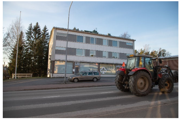
Korttelissa 77 sijaitseva asuin- ja liikeyrakennus, jonka katutasossa on kiinteistöväälitystoimisto ja tyhjillään oleva liikeyhuoneisto. Rakennus on rakennettu vuonna 1962.
