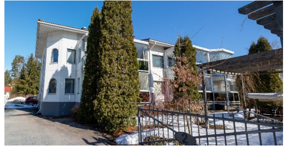
Liikerakennuksen takana samalla rakennuspaikalla sijaitseva asuinkerrostalo. Rakennukset on rakennettu vuonna 1992.
