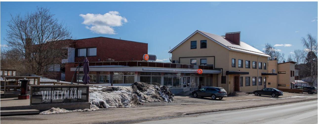
Etualalla yksikerroksinen Osuuspankin vuonna 1978 rakennettu laajennusosa, joka rakennettu kiinni vuonna 1954 rakennettuun liike- ja asuinrakennukseen sekä vuonna 1970 rakennettuun asuinkerrostaloon.
