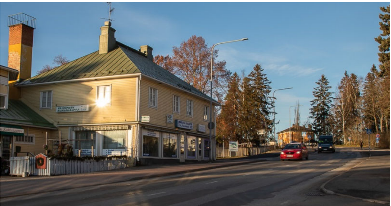
Onkkaalantietä entisen Osuusliike Tuotannon rakennuksen kohdalla. Katualuetta on korotettu tien loiventamiseksi. Rakennukset ja niiden piha-alueet ovat jääneet tienpintaa alemmaksi.
