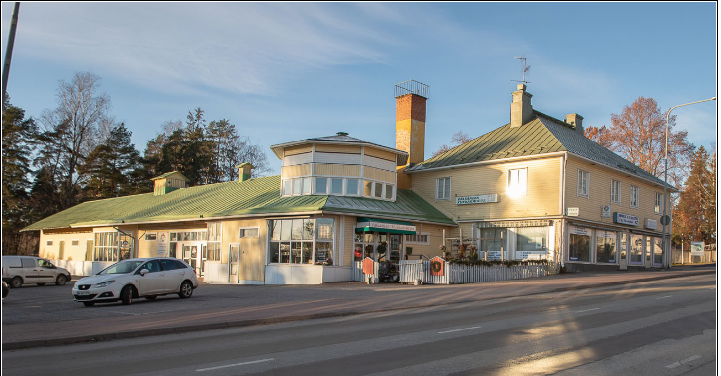
Onkkaalantie 71 kuvattuna syksyllä 2021. Valokuva: Helena Väisänen.
