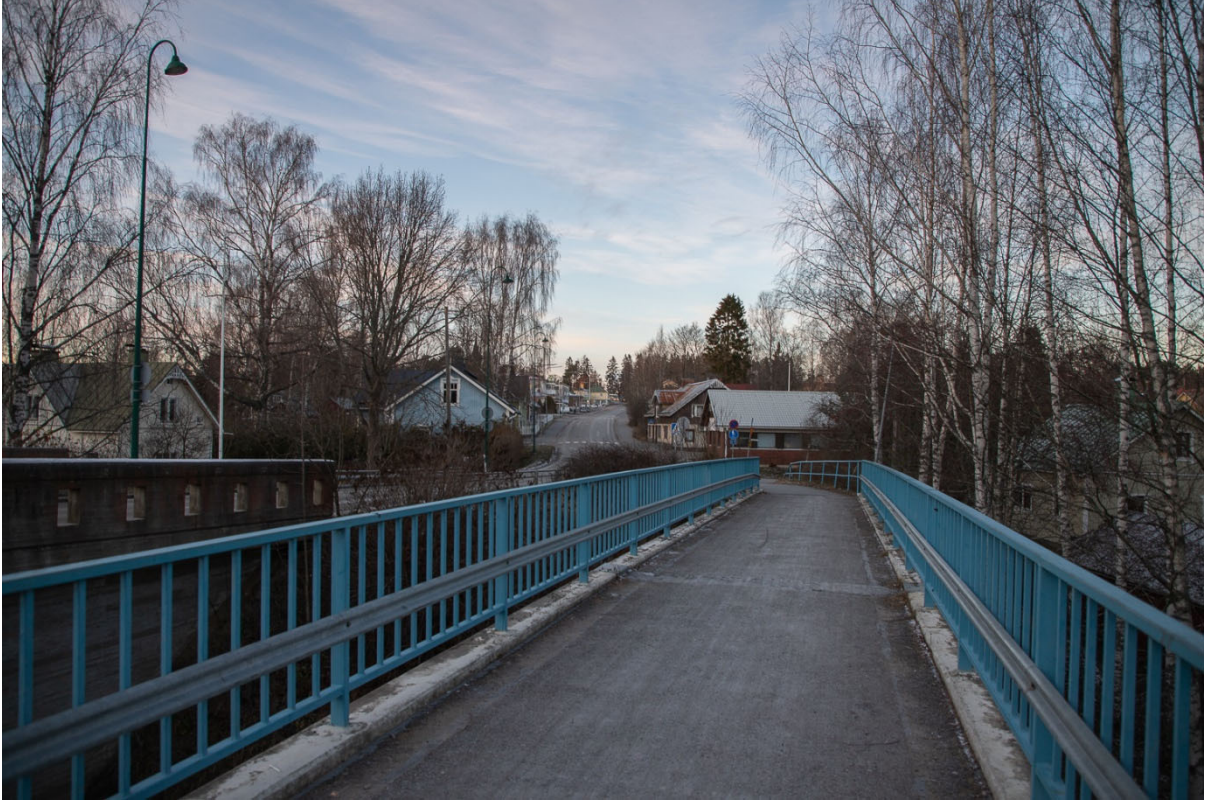
Näkymä Kostian sillalta pohjoiseen päin.
