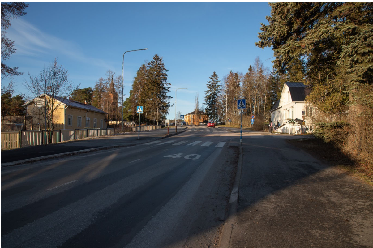
Näkymä Haanloukkaantien risteyksen kohdalta pohjoiseen.
